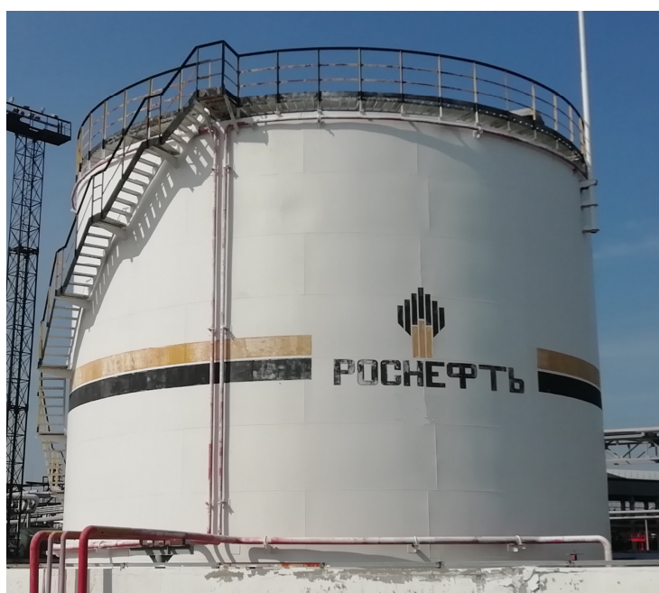
Рисунок 1 – Общий вид резервуаров РВС-2000
