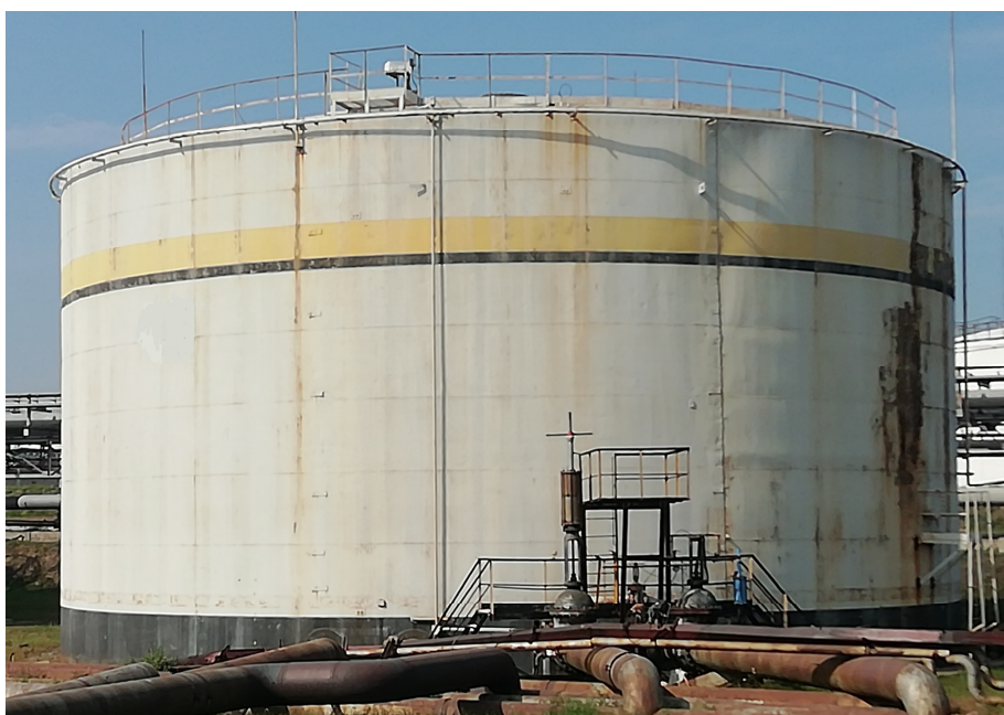
Рисунок 1 – Общий вид резервуаров РВС-5000
