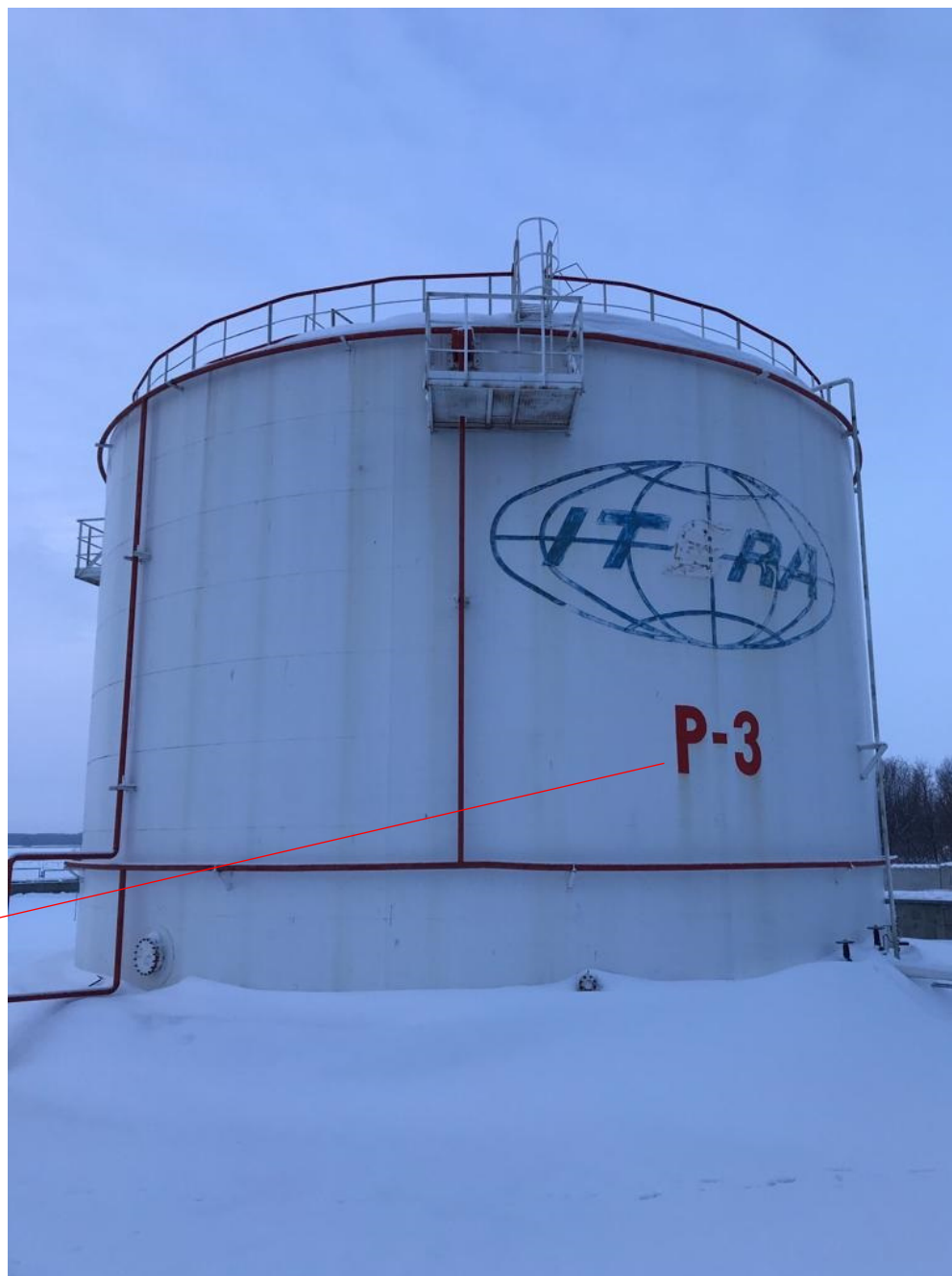
Рисунок 1 - Общий вид резервуара вертикального стального цилиндрического РВС-3000 заводской номер Р-3 с указанием места нанесения заводского номера
