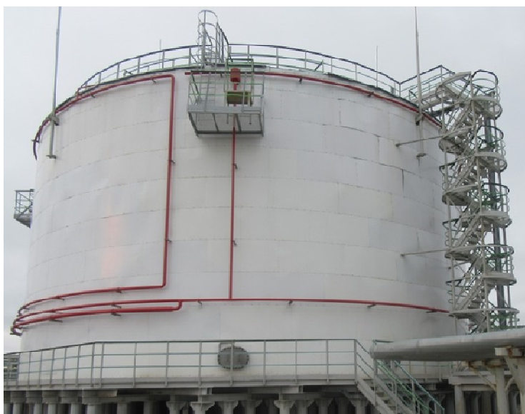
Рисунок 1 – Общий вид резервуара РВС-5000
