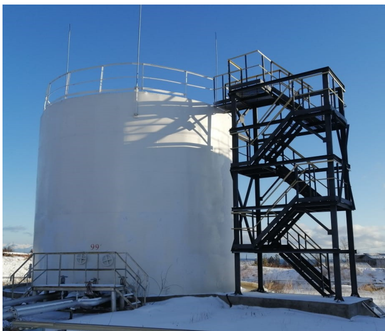
Рисунок 1 – Общий вид резервуаров РВС-400
