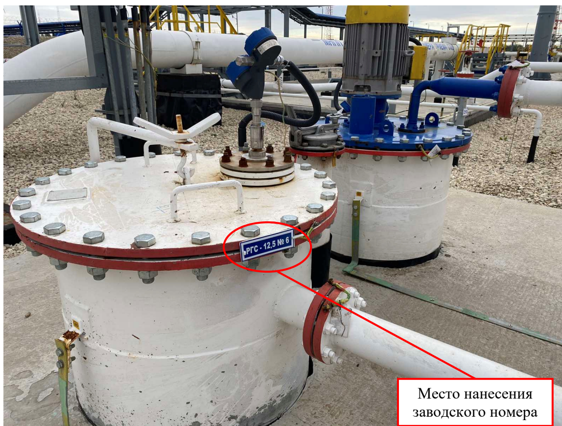
Рисунок 2 – Общий вид надземной части резервуара стального горизонтального цилиндрического РГС-12,5 с указанием места нанесения заводского номера
