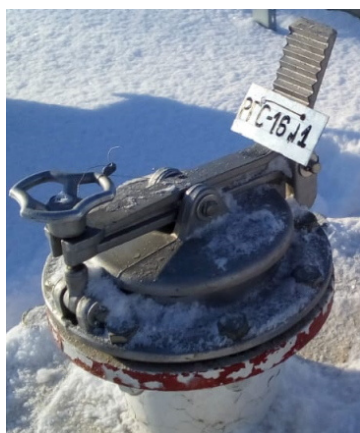
Рисунок 13 – Фотография горловины и заводского номера резервуара стального горизонтального цилиндрического РГС, модификации РГС-16, заводской номер 1
