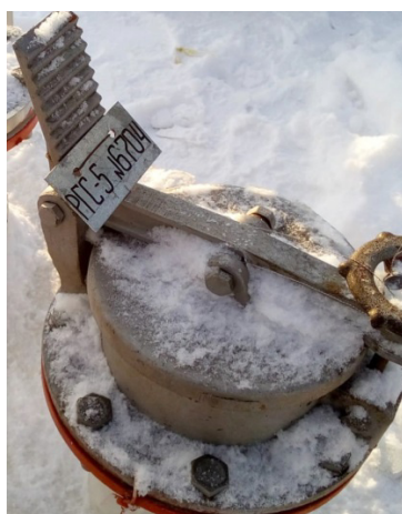
Рисунок 6 – Фотография горловины и заводского номера резервуара стального горизонтального цилиндрического РГС, модификации РГС-5, заводской номер 6704
