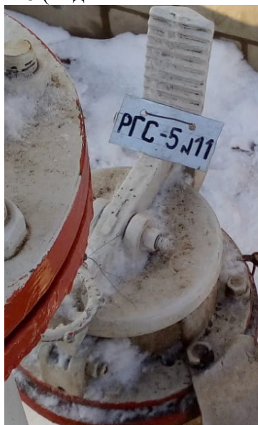
Рисунок 5 – Фотография горловины и заводского номера резервуара стального горизонтального цилиндрического РГС, модификации РГС-5, заводской номер 11
