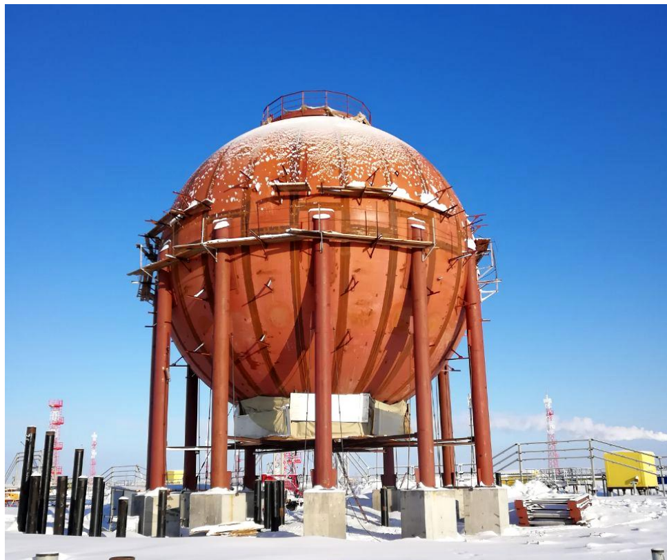
Рисунок 1 - Общий вид резервуара РШС-2000
