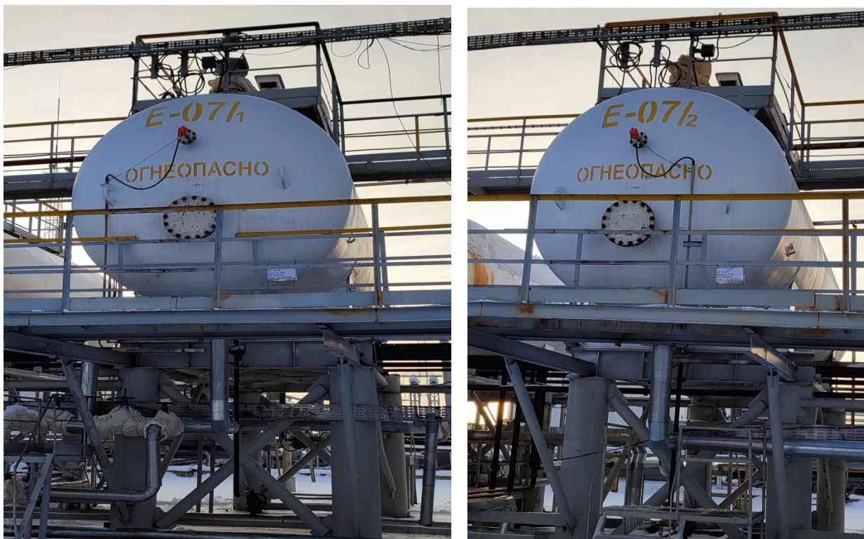
Рисунок 1 – Общий вид РГС-80
