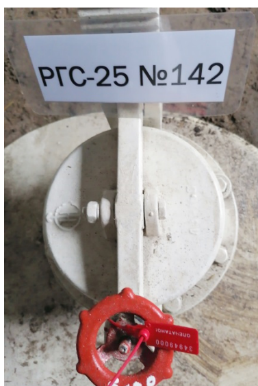
Рисунок 2 – Фотография горловины и заводского номера резервуара стального горизонтального цилиндрического РГС-25, заводской номер 1
