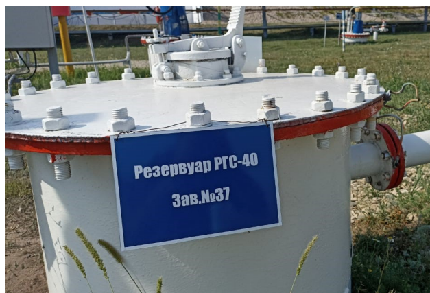
Рисунок 1 - Место нанесения заводских номеров резервуаров РГС-40
