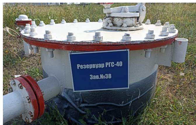
Рисунок 1 - Место нанесения заводских номеров резервуаров РГС-40
