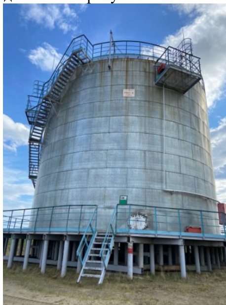
Рисунок 1 - Общий вид резервуара
