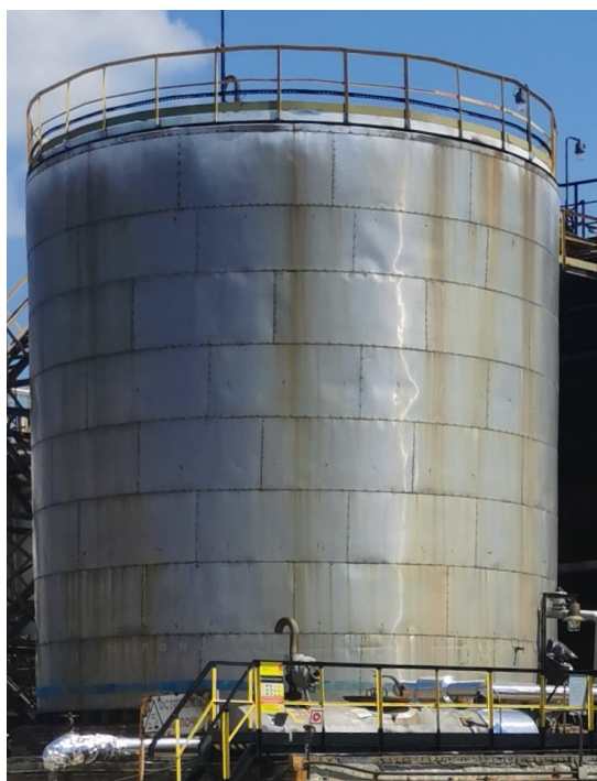
Рисунок 1 – Общий вид резервуаров РВС-500
