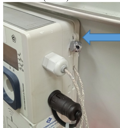
Монтаж термопреобразователя сопротивления Pt500 (500П) на корпусе счетчика Рисунок 4 – Схема пломбировки от несанкционированного доступа места присоединения преобразователя температуры, обозначение места нанесения знака поверки
