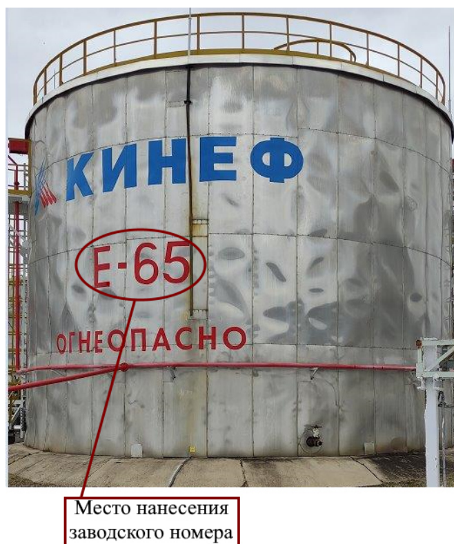
Рисунок 2 – Общий вид резервуара РВС-1000 зав.№ Е-65 с указанием места нанесения заводского номера
