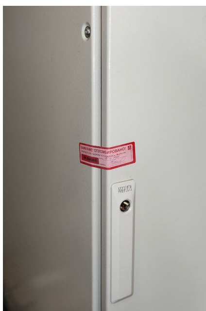
Рисунок 4 – Схема пломбировки шкафа СОИ
