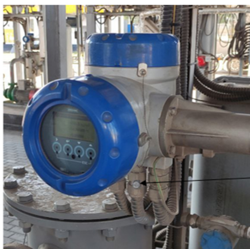
Рисунок 5 – Схема пломбировки преобразователем сигналов MFC 400C OPTIMASS
