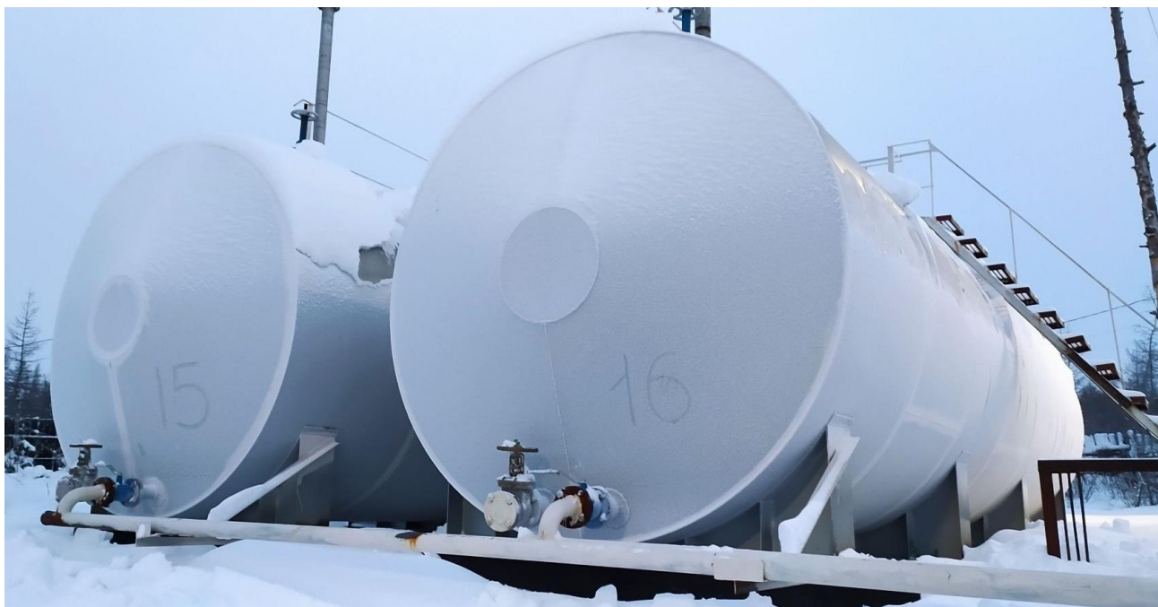
Рисунок 2 – Общий вид резервуаров РГС-60
