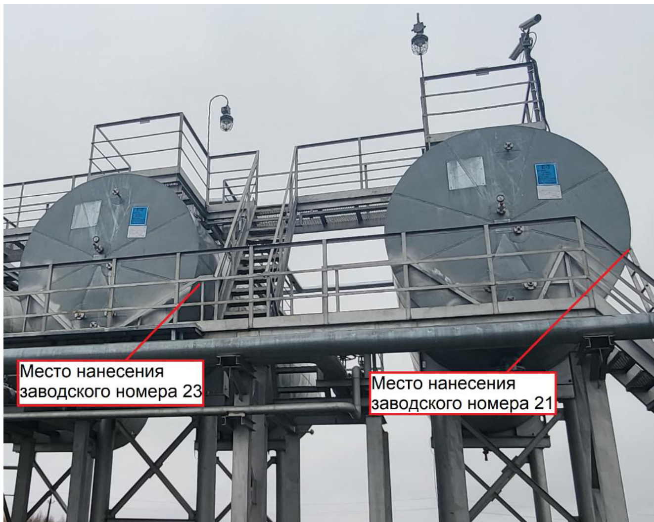
Рисунок 1 - Общий вид резервуаров горизонтальных стальных цилиндрических РГС- 80 с указанием места установки таблички с заводским номером
