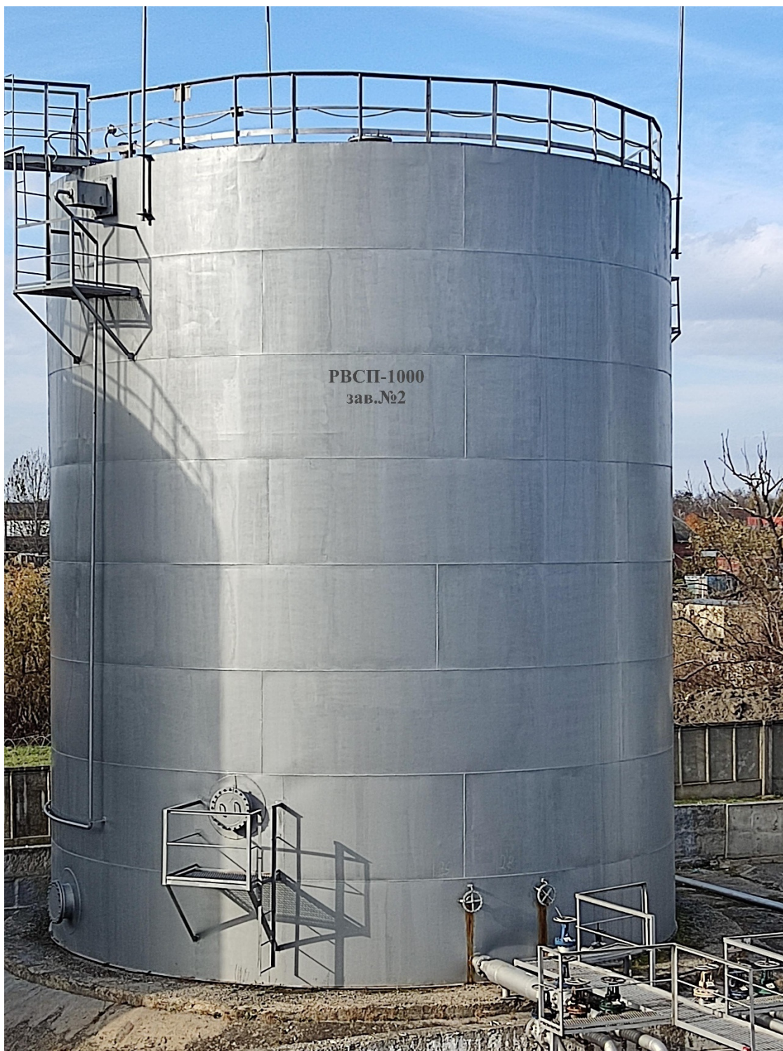
Рисунок 1 - Фотография общего вида резервуара РВСП-1000 заводской номер 2
