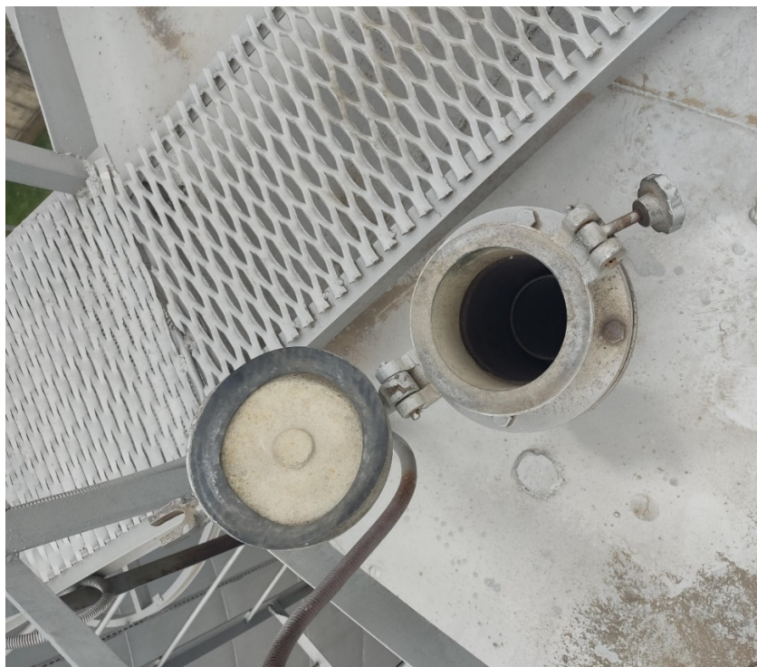
Рисунок 3 – Фотография горловины замерного люка резервуара РВСП-1000 заводской номер 2
