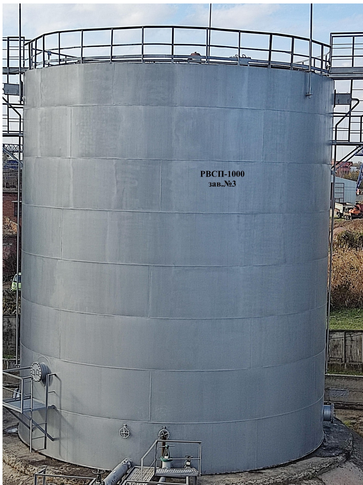
Рисунок 2 - Фотография общего вида резервуара РВСП-1000 заводской номер 3
