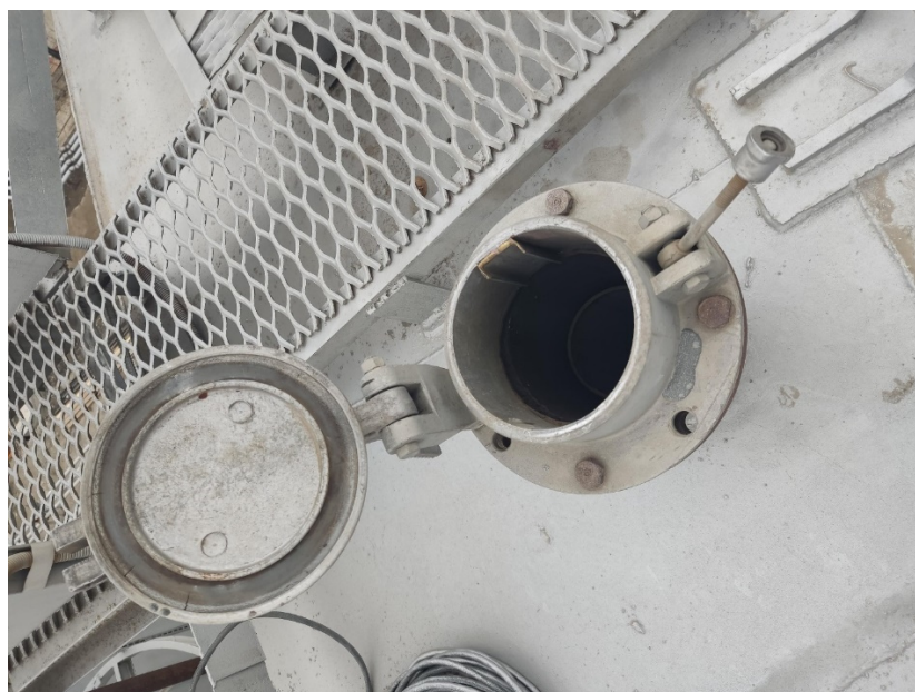
Рисунок 4 - Фотография горловины замерного люка резервуара РВСП-1000 заводской номер 3
