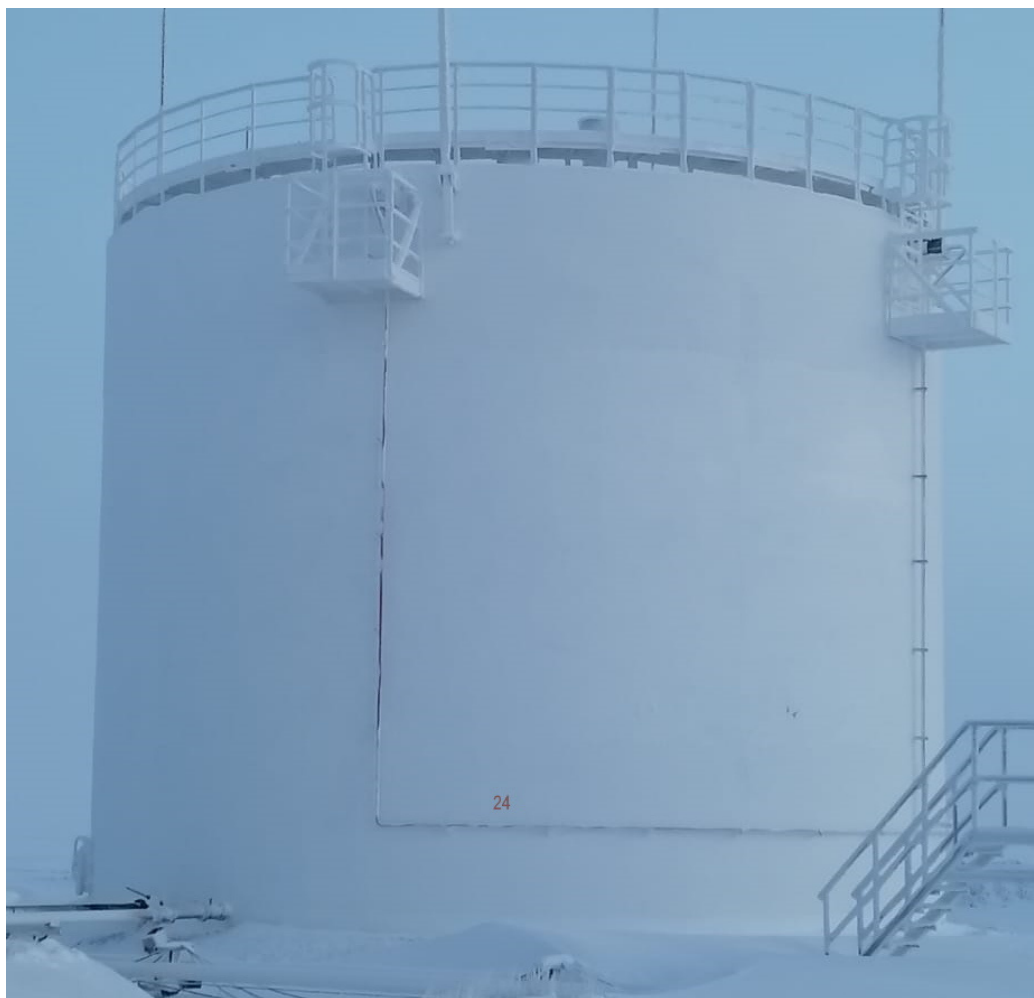
Рисунок 1 – Общий вид резервуара РВС-2000
