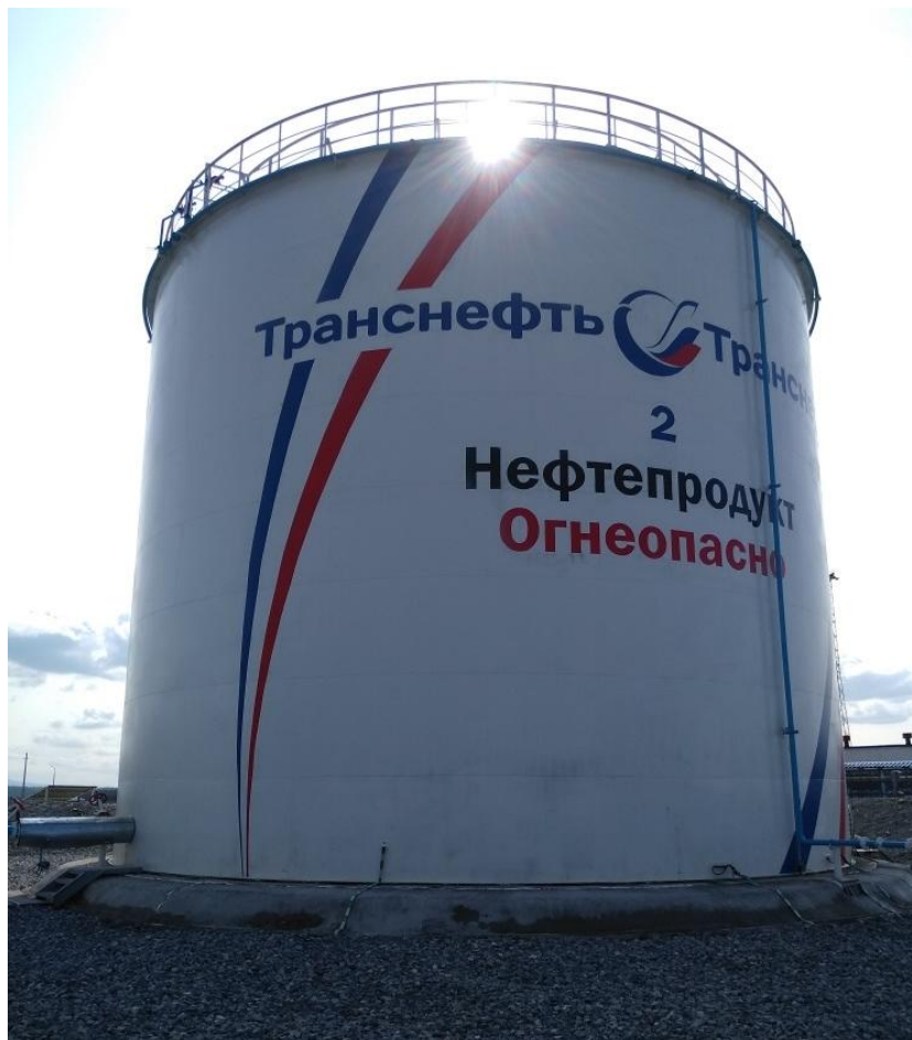
Рисунок 1 - Общий вид резервуара вертикального стального цилиндрического РВС-2000
