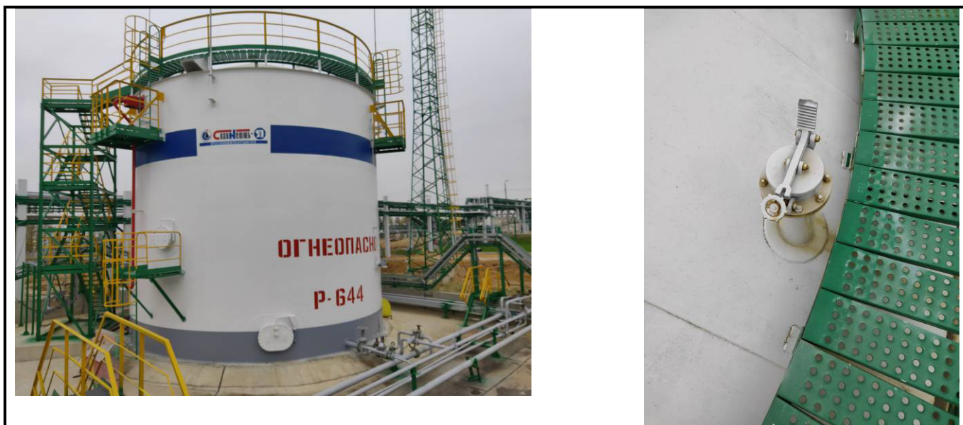
Рисунок 7 – Общий вид резервуара РВСП-700 (№P-644) с замерным люком
