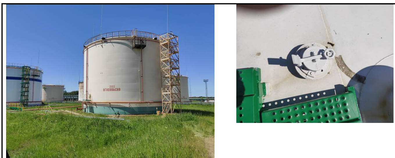
Рисунок 12 – Общий вид резервуара РВСII-5000 (№260) с замерным люком
