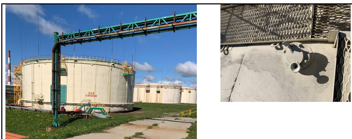
Рисунок 17 – Общий вид резервуара РВСП-10000 (№253) с замерным люком
