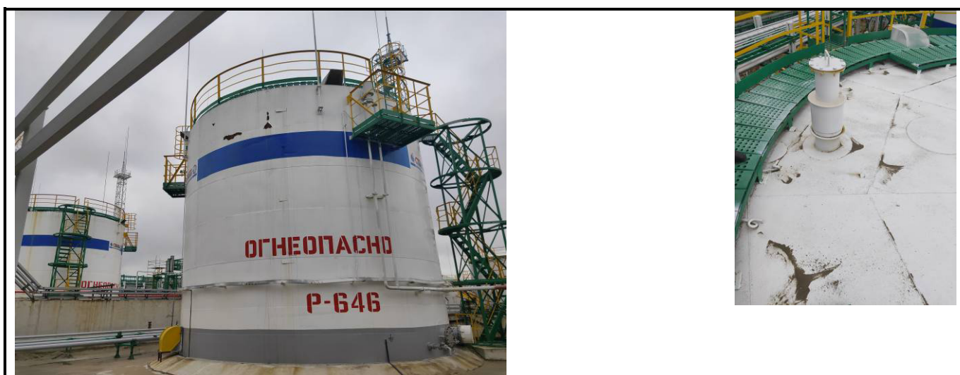
Рисунок 9 – Общий вид резервуара РВСП-700 (№646) с замерным люком
