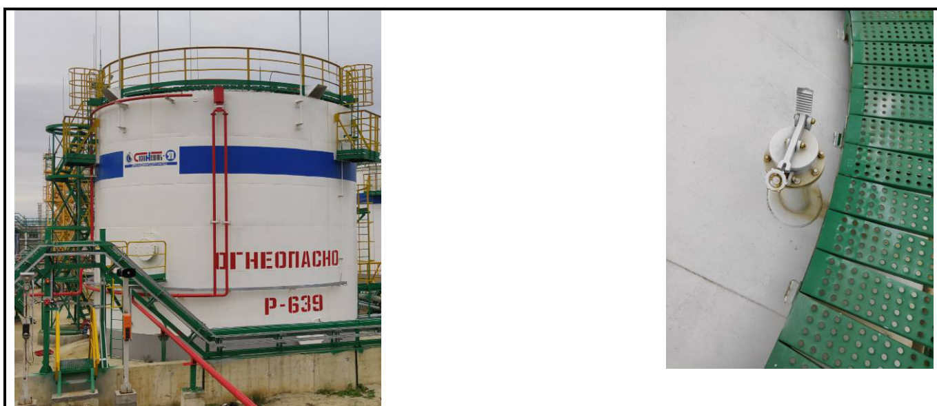
Рисунок 2 – Общий вид резервуара РВСП-700 (№P-639) с замерным люком
