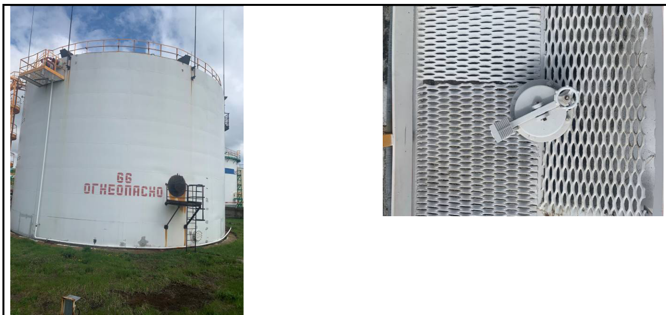
Рисунок 10 – Общий вид резервуара РВСII-3000 (№66) с замерным люком
