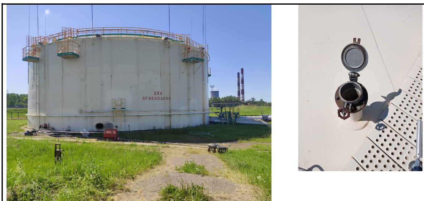
Рисунок 18 – Общий вид резервуара РВСП-10000 (№254) с замерным люком
