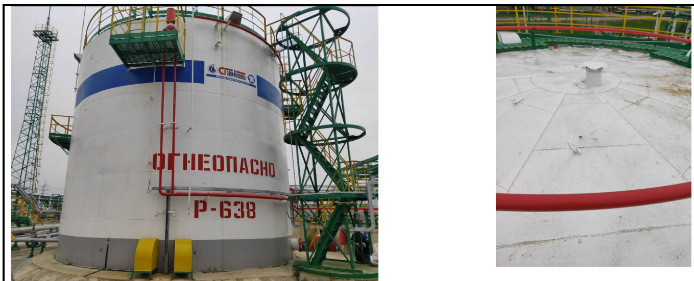
Рисунок 1 – Общий вид резервуара РВСП-700 (№P-638) с замерным люком
