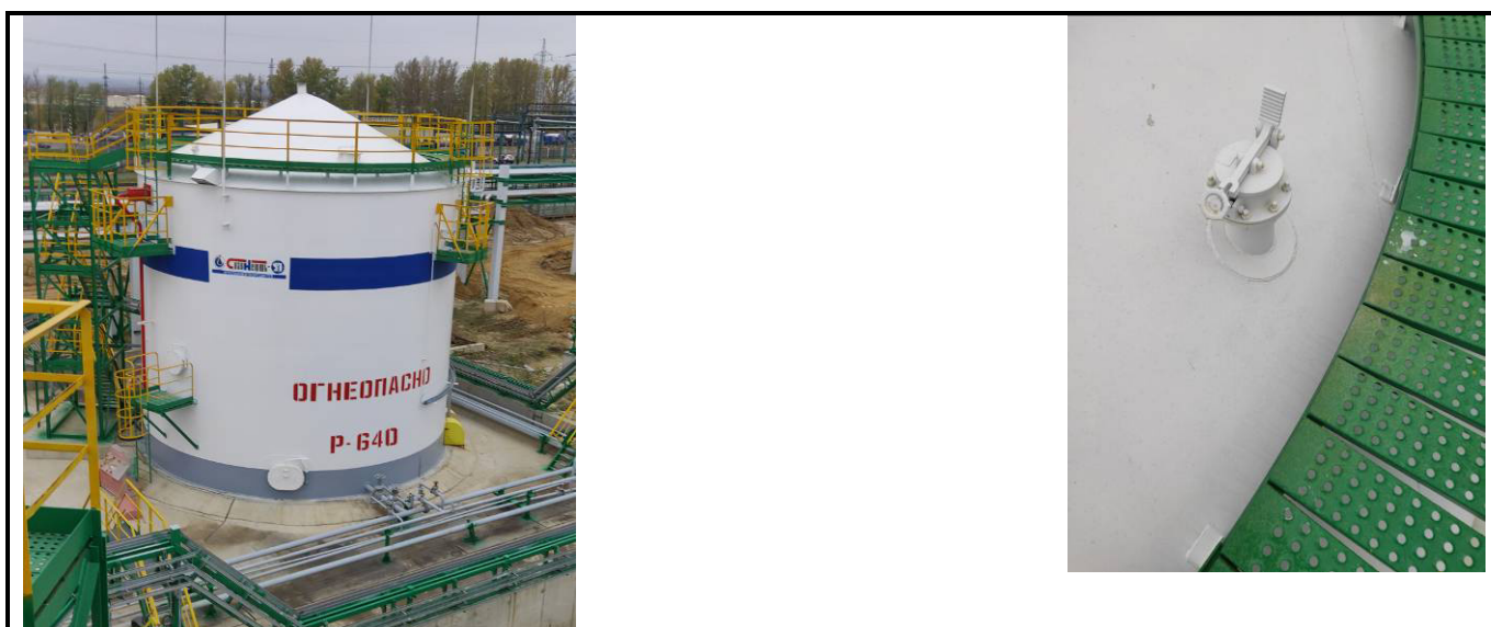
Рисунок 3 – Общий вид резервуара РВСП-700 (№P-640) с замерным люком
