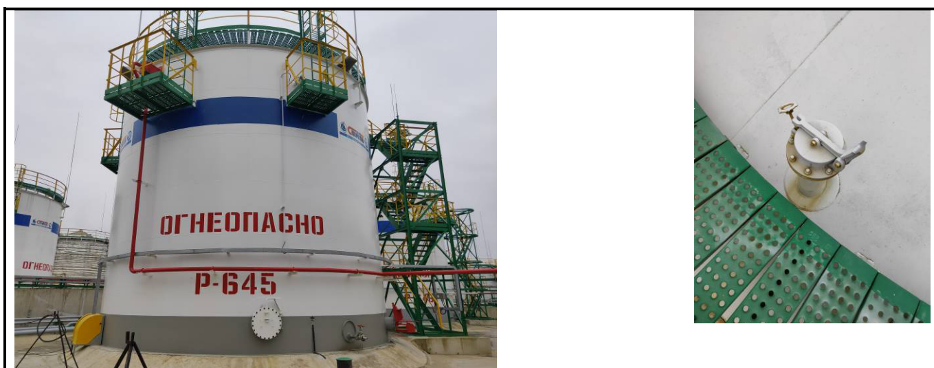
Рисунок 8 – Общий вид резервуара РВСП-700 (№P-645) с замерным люком
