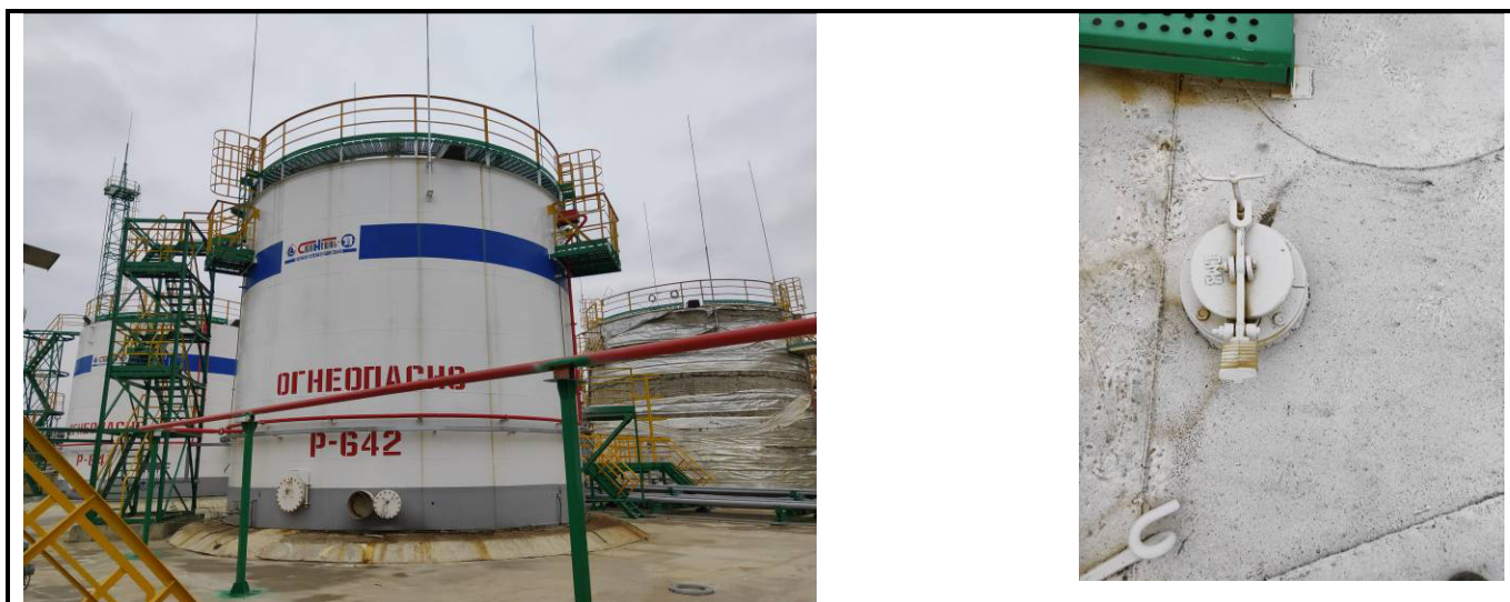
Рисунок 5 – Общий вид резервуара РВСП-700 (№Р-642) с замерным люком
