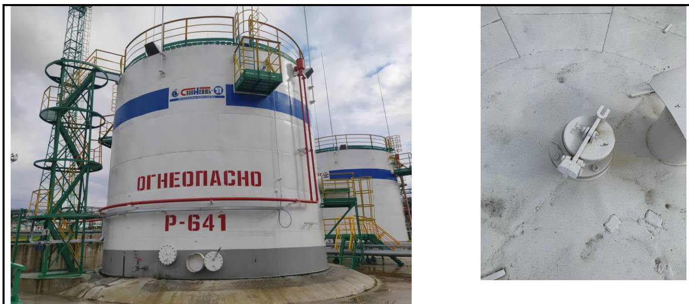
Рисунок 4 – Общий вид резервуара РВСП-700 (№Р-641) с замерным люком
