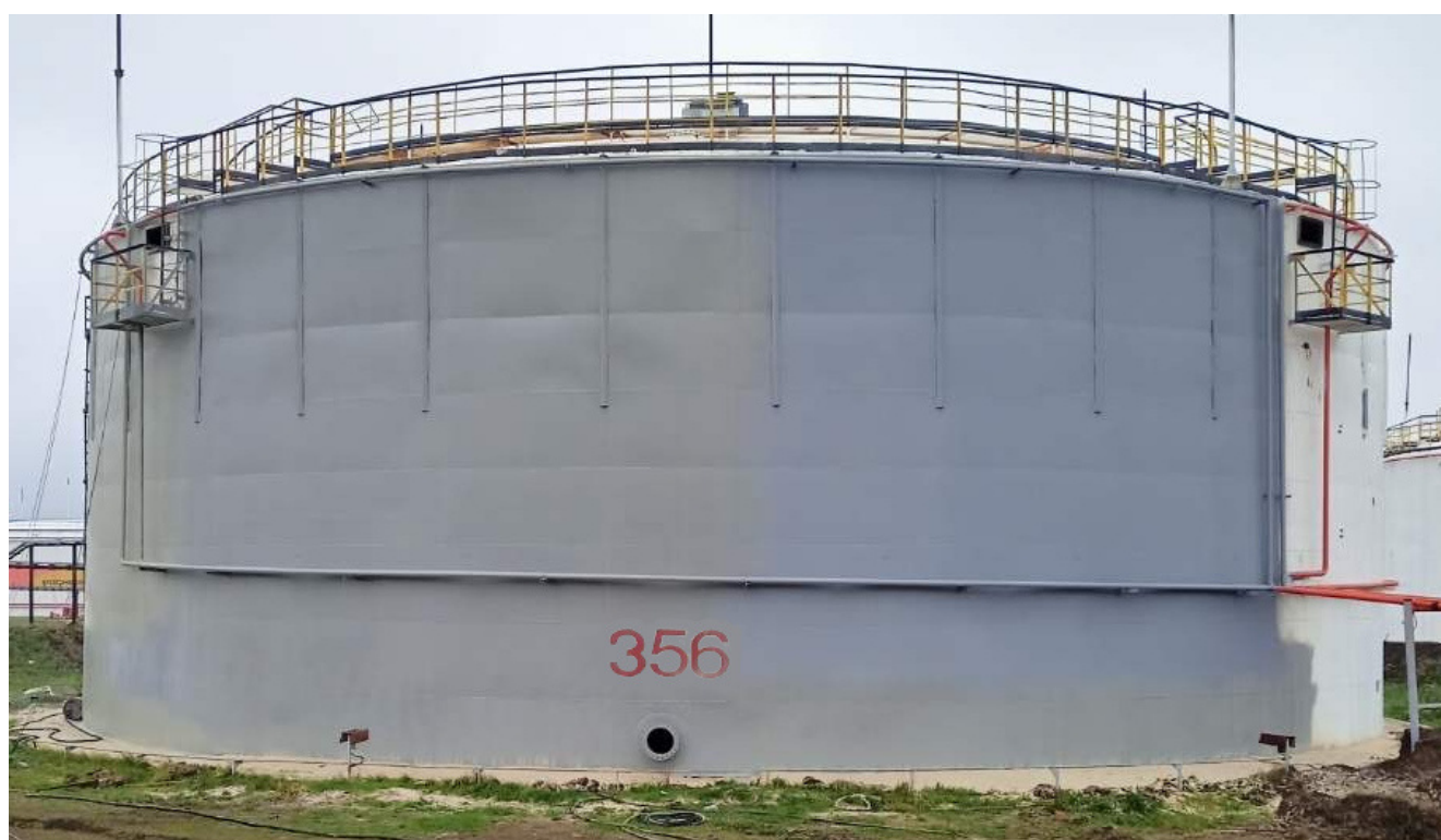
Рисунок 4 – Общий вид резервуара РВС-10000 №356
