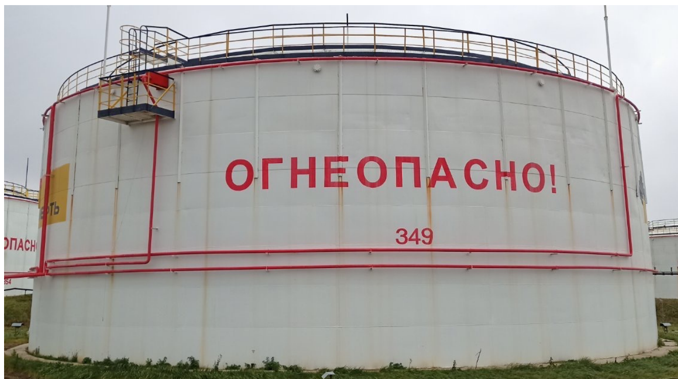
Рисунок 1 – Общий вид резервуара РВС-10000 №349
