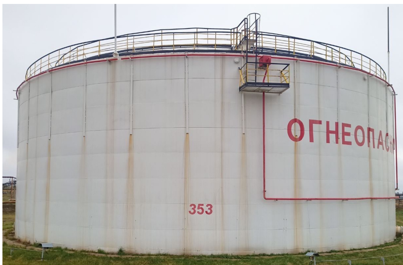
Рисунок 2 – Общий вид резервуара РВС-10000 №353
