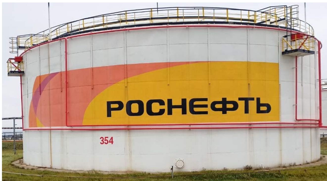
Рисунок 3 – Общий вид резервуара РВС-10000 №354
