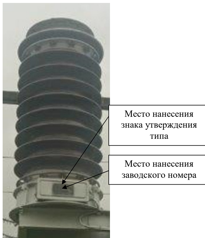
Рисунок 1 - Общий вид трансформаторов напряжения с указанием места нанесения знака утверждения типа, места нанесения заводского номера
