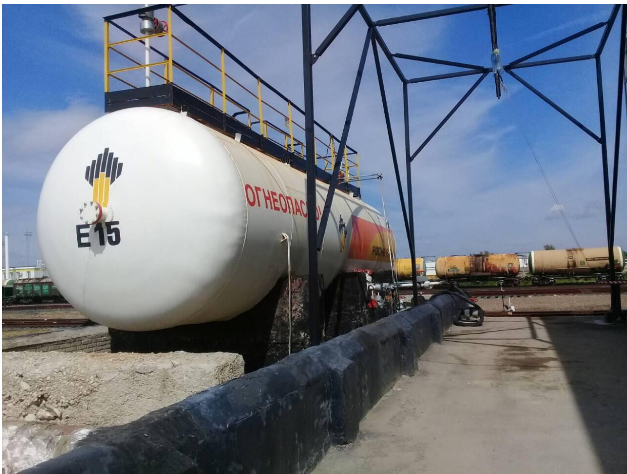
Рисунок 1 - Общий вид резервуара стального горизонтального цилиндрического РГС-80
