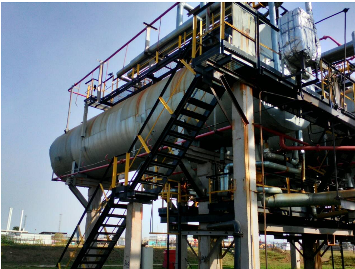
Рисунок 2 - Общий вид резервуара стального горизонтального цилиндрического РГС-100
