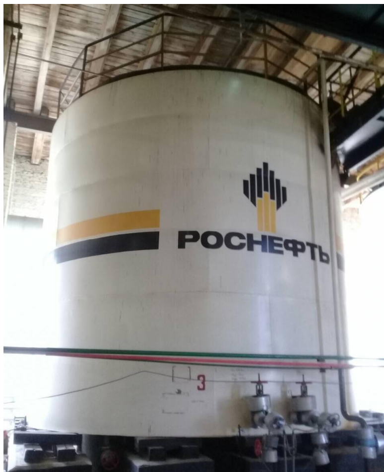
Рисунок 1 - Общий вид резервуара стального вертикального цилиндрического РВС-200
