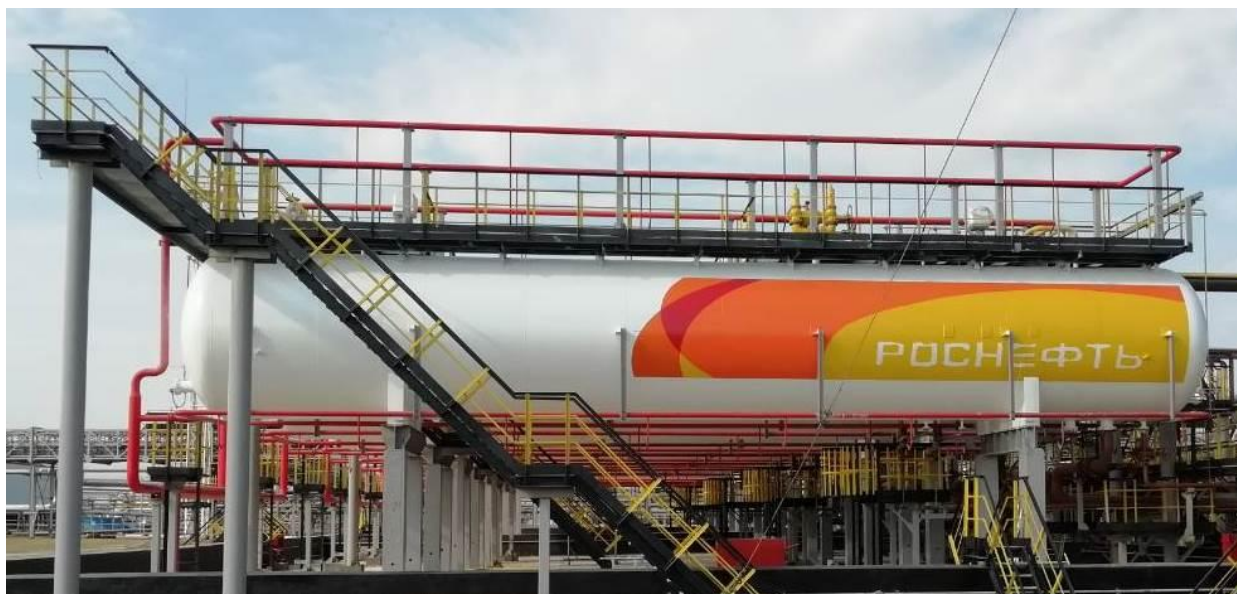
Рисунок 1 - Общий вид резервуара стального горизонтального цилиндрического РГС-200
