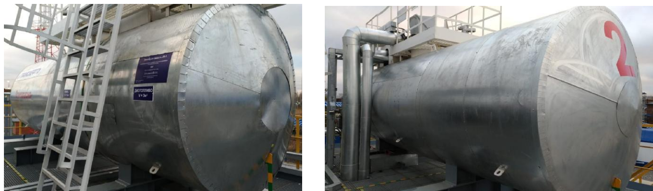
Рисунок 1 - Общий вид резервуаров
